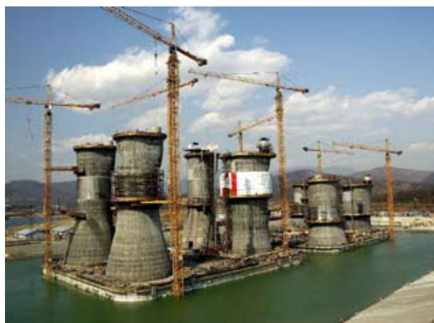
Die Plattformen werden am Festland gebaut und danach geflutet, um sie anschließend mit Schleppschiffen 1500 km weit an ihren Bestimmungsort auf das offene Meer zu bringen.
