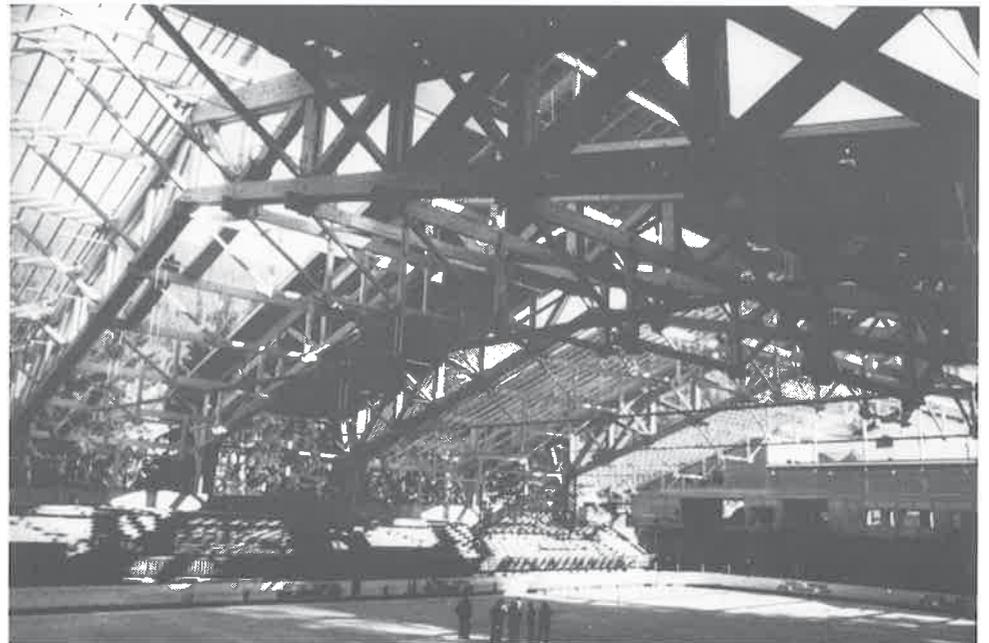
Bild 3. Sporthalle in fachwerkartiger Holzleimkonstruktion
