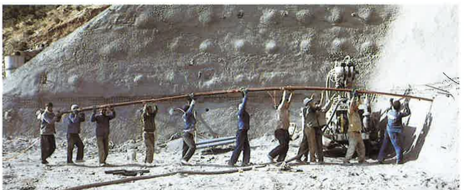
Einbau eines Bodennagels
