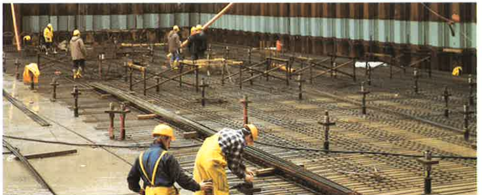
Auftriebssicherung einer Docksohle mit GEWI-Pfählen \varnothing 63,5 mm
