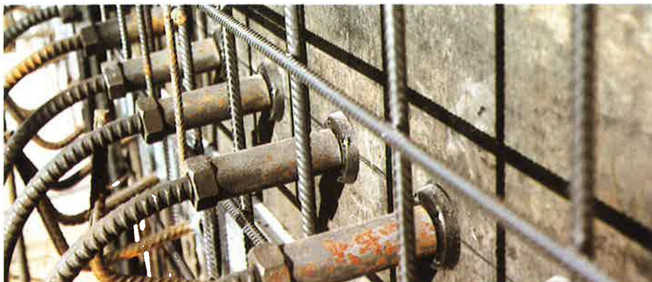
GEWI-Anschlußbewehrung, gebogene Muffenstäbe
