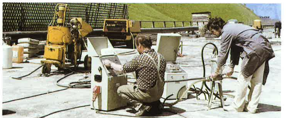
Vakuumverpressen von Spannkanaelen
