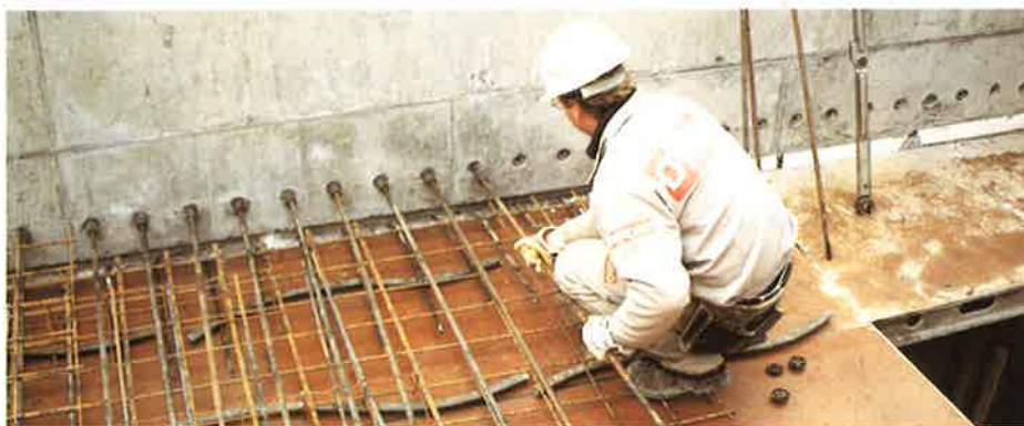
GEWI-Anschlußbewehrung, gerade Anschlußstäbe
