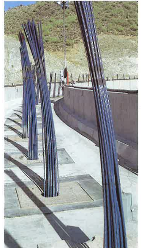
Gleitsicherung einer Staumauer mit epoxy-beschichteten Litzenankern
