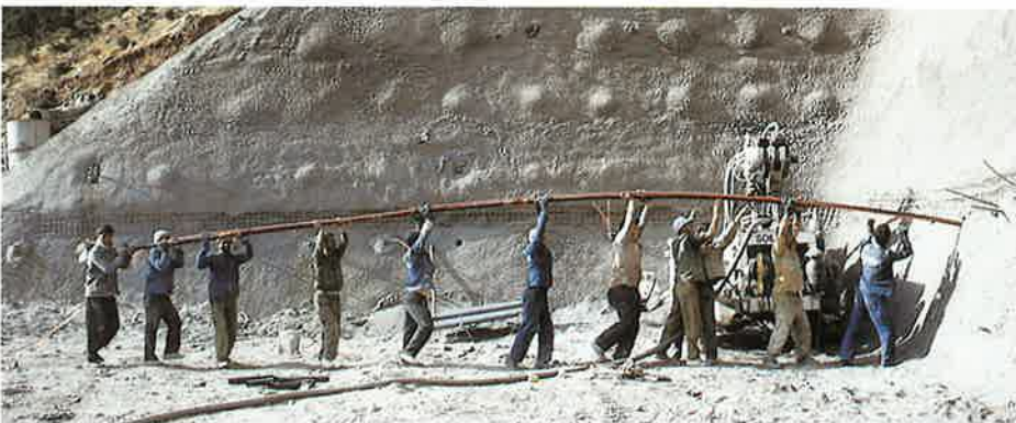
Einbau eines Bodennagels
