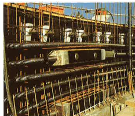
Zwischenkopplung M
