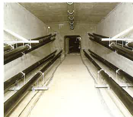
Bündelspannglieder externe Vorspannung
