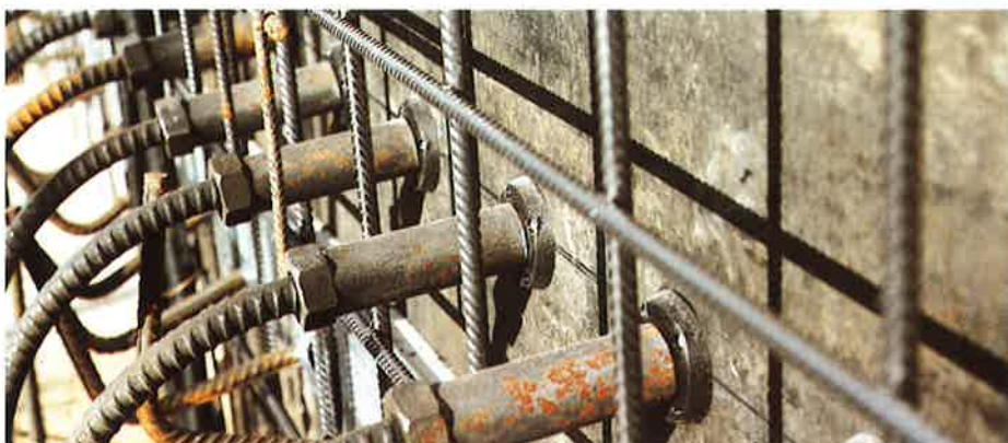
GEWI-Anschlußbewehrung, gebogene Muffenstäbe
