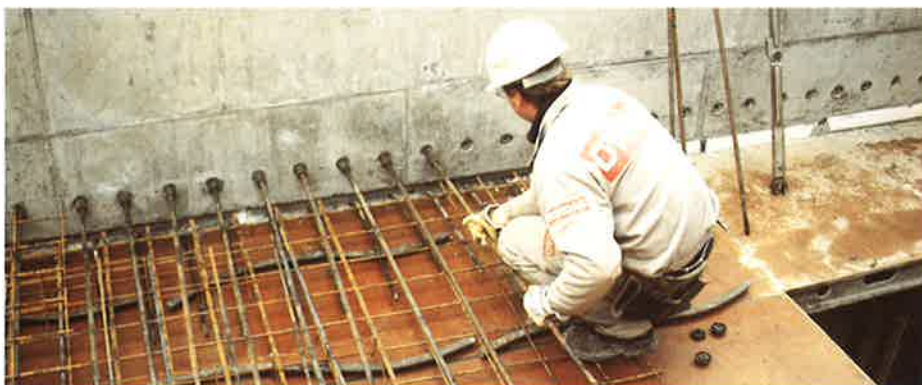
GEWI-Anschlußbewehrung, gerade Anschlußstäbe
