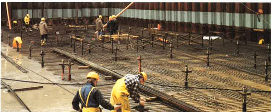
Auftriebssicherung einer Docksohle mit GEWI-Pfählen \varnothing 63,5 mm
