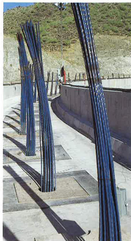
Gleitsicherung einer Staumauer mit epoxy-beschichteten Litzenankern
