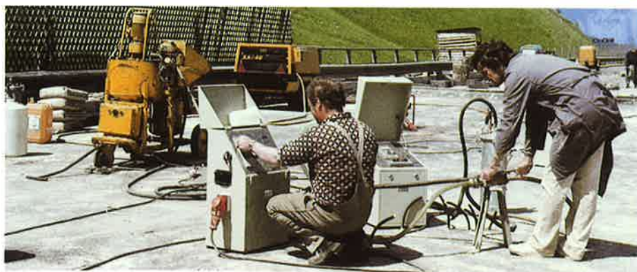
Vakuumverpressen von Spannkanälen
