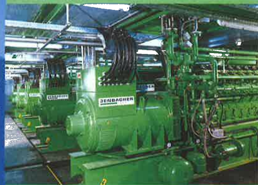
Deponiegasverstromung, Rautenweg, Wien Anlagenleistung: 8 MW
